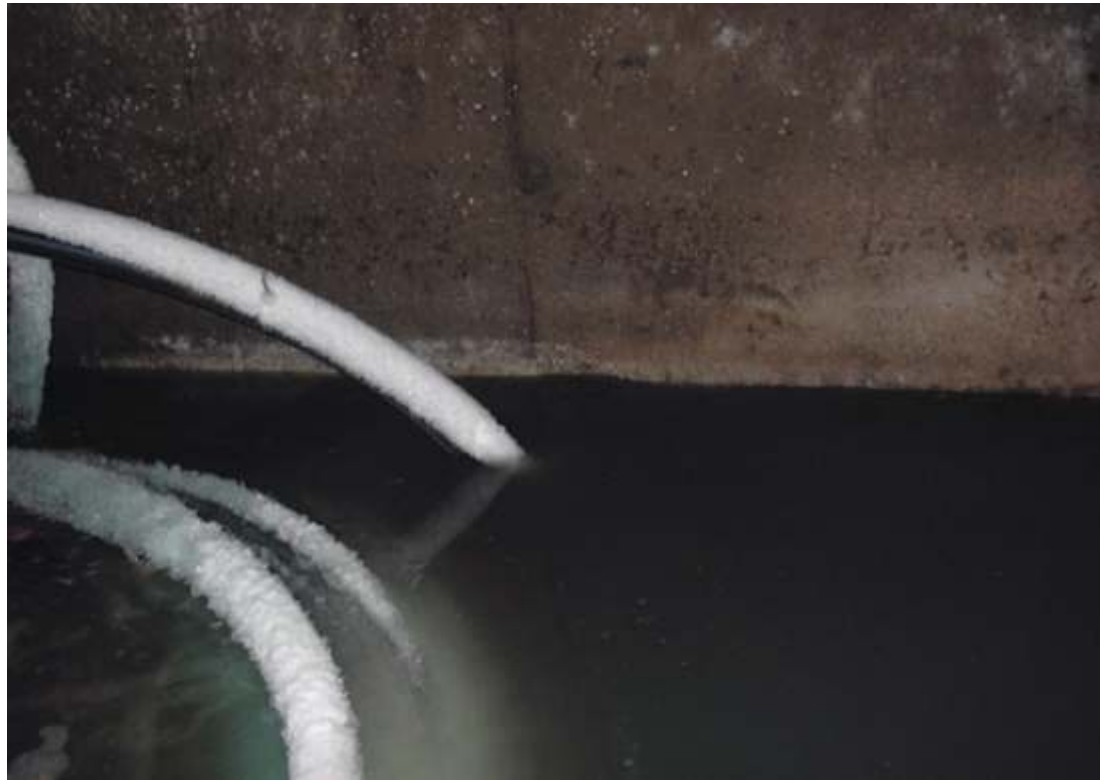
Pohled do zamrzající odpadní jímky
